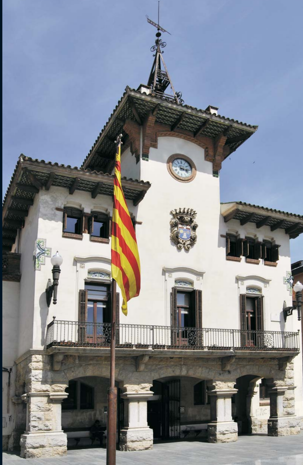
38 Ajuntament. Obra de J. Domènech Mansana, 1926
