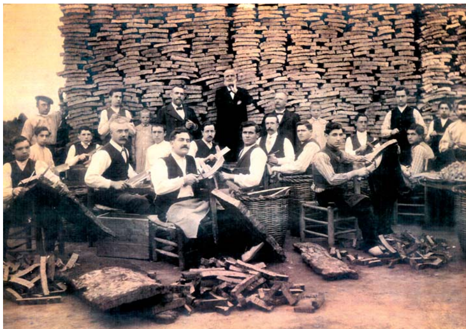
Fàbrica de taps de cal Menut, 1907
