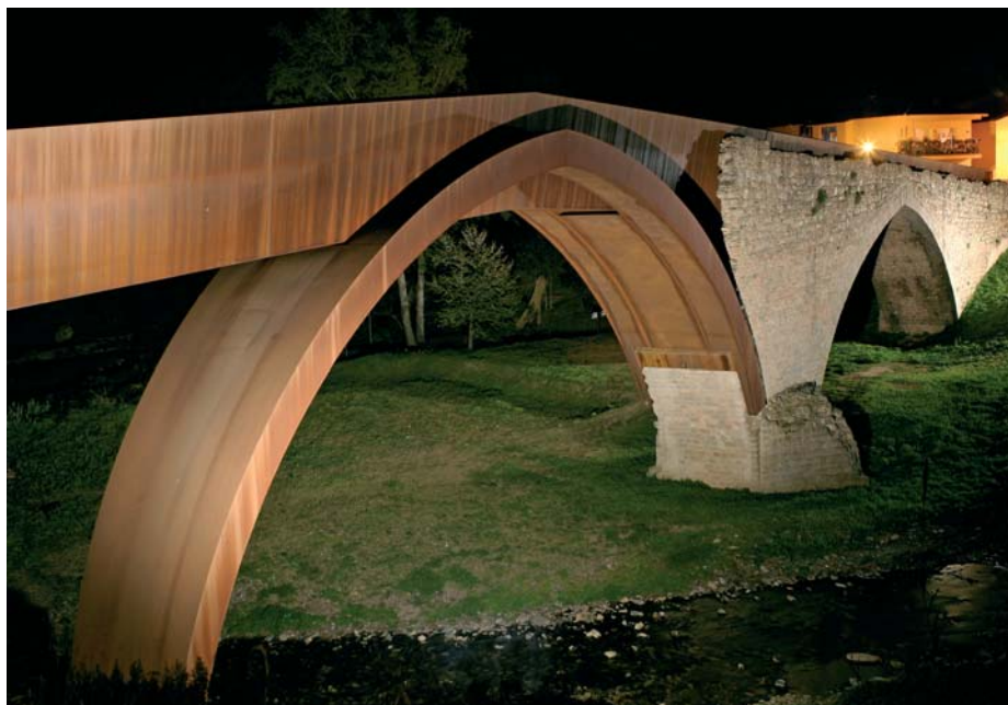
6 Arc gòtic i nova estructura metàl·lica del Pont Trencat
