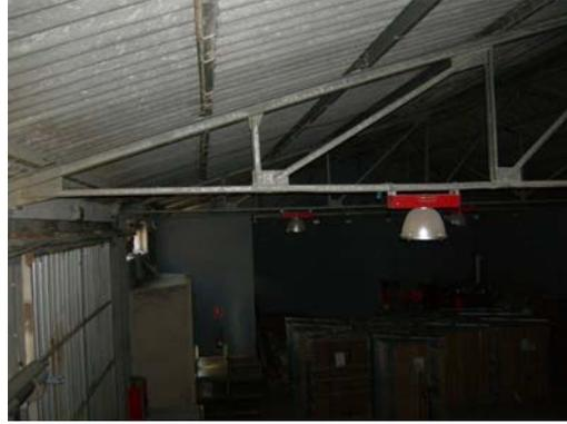
Detalle sujeción cubierta
