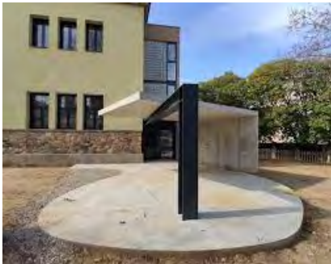
Accés edifici carrer del Grup Escolar-plataformes formigó
