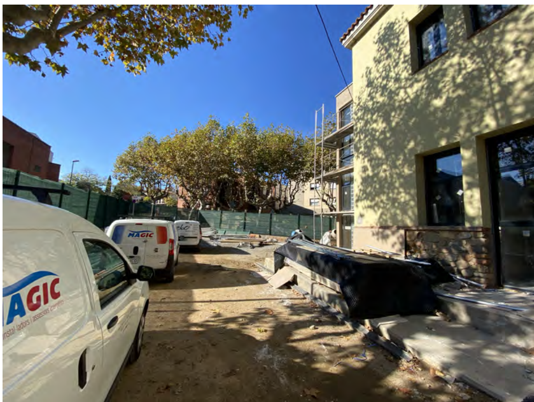
Rampes i plataformes de formigó perimetrals edifici façana carrer del Grup Escolar
