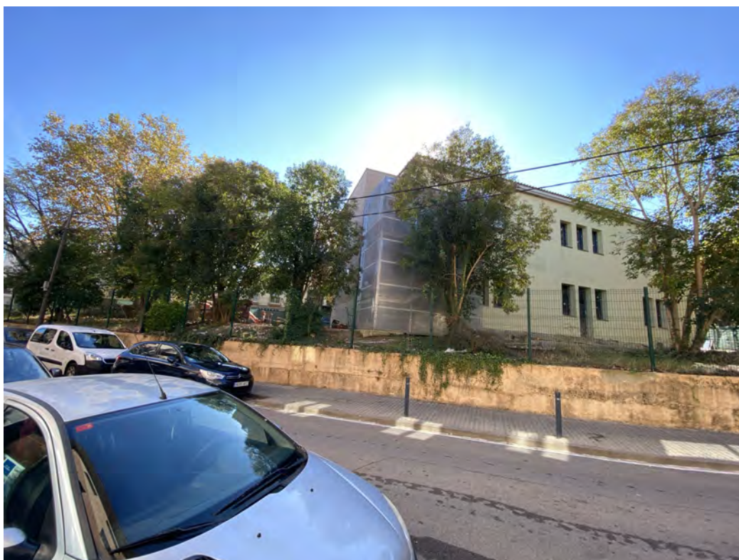
Murs i tanques metàl·liques tancament parcel·la Carrer Ramis. Vegetació i arbrat
