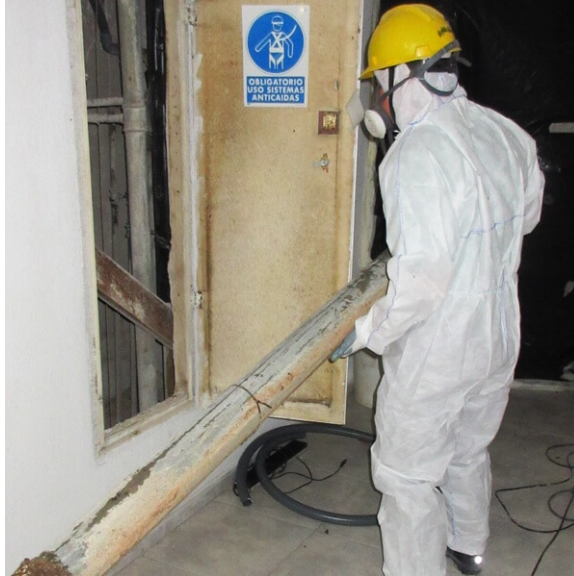
Figura A3.22 Desmuntatge de peces senceres per a la retirada d'una baixant de fibrociment
