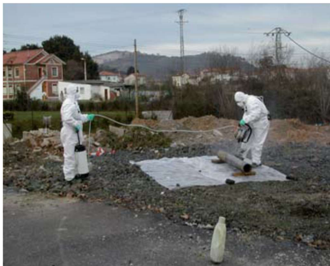
Figura A3.3 Assaig de diferents eines de treball per a cort de canonada. La col·locació d'una làmina de plàstic en el sòl evita la disseminació dels residus i facilita la seua recollida i neteja de la zona
