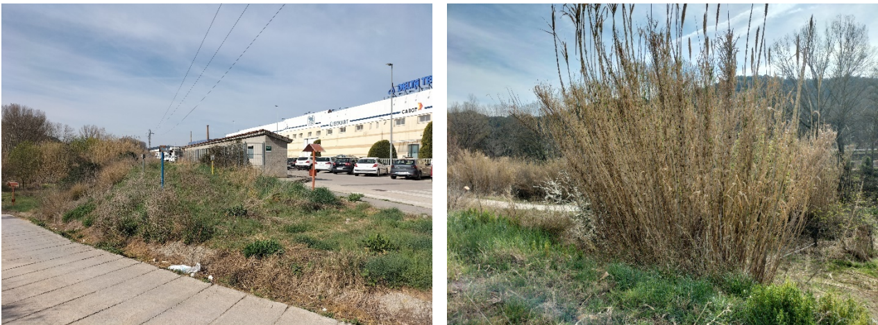
Figura 7 Registres de d'instal·lacions soterrades i canyes (Arundo donax). Tram 2
