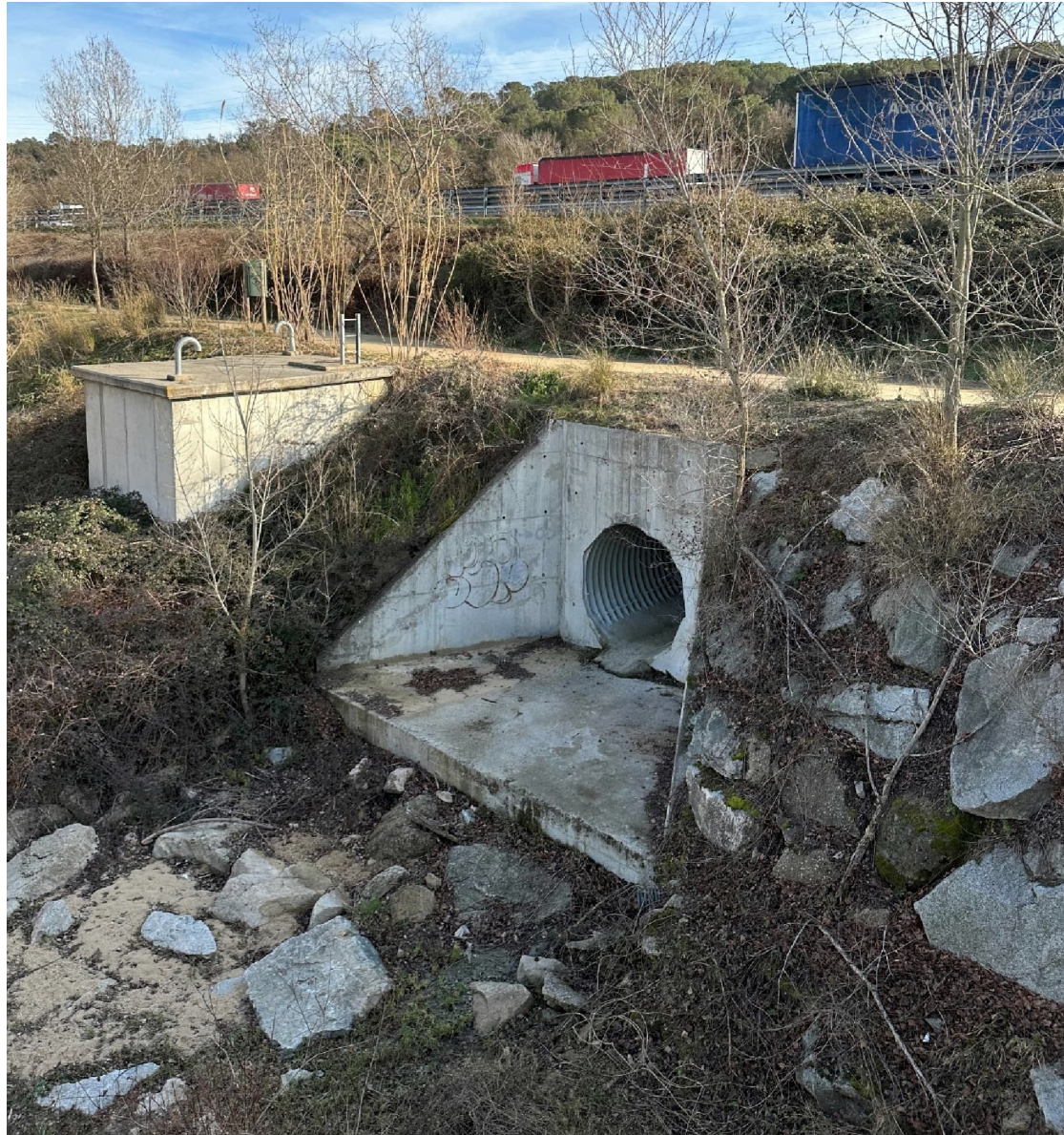
Fotografia 6 Obra de fàbrica existent
