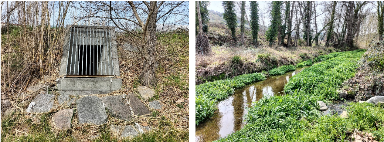
Figura 11 Sobreeixidor i acumulació d'aigües residuals al costat del Tordera
