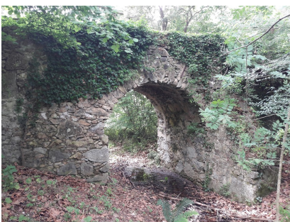
Pont de pedra a la finca de Can Valls
