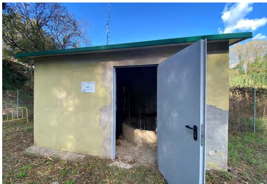
Figura 1. Exterior caseta Pou Palautordera.
