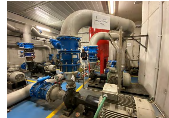
Figura 18 - Bombament elevació fins dipòsit Turó.
