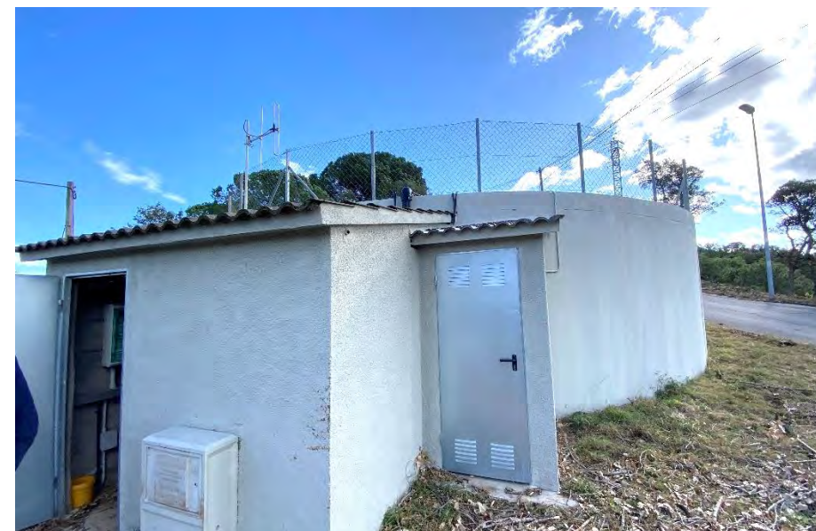
Figura 30. Exterior dipòsit Boscos Montnegre.
