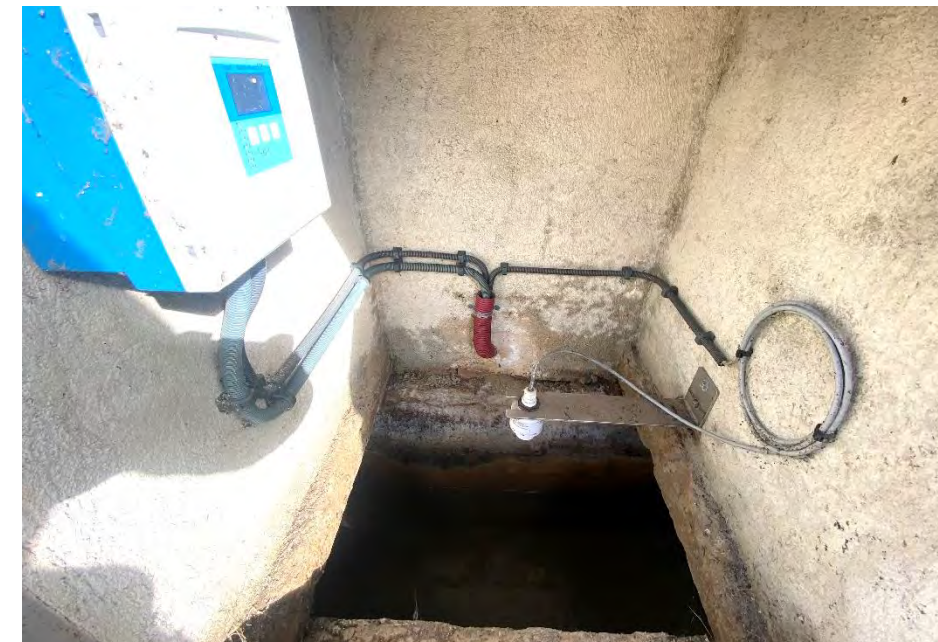
Figura 66. Parshall. Sensor de nivell.
