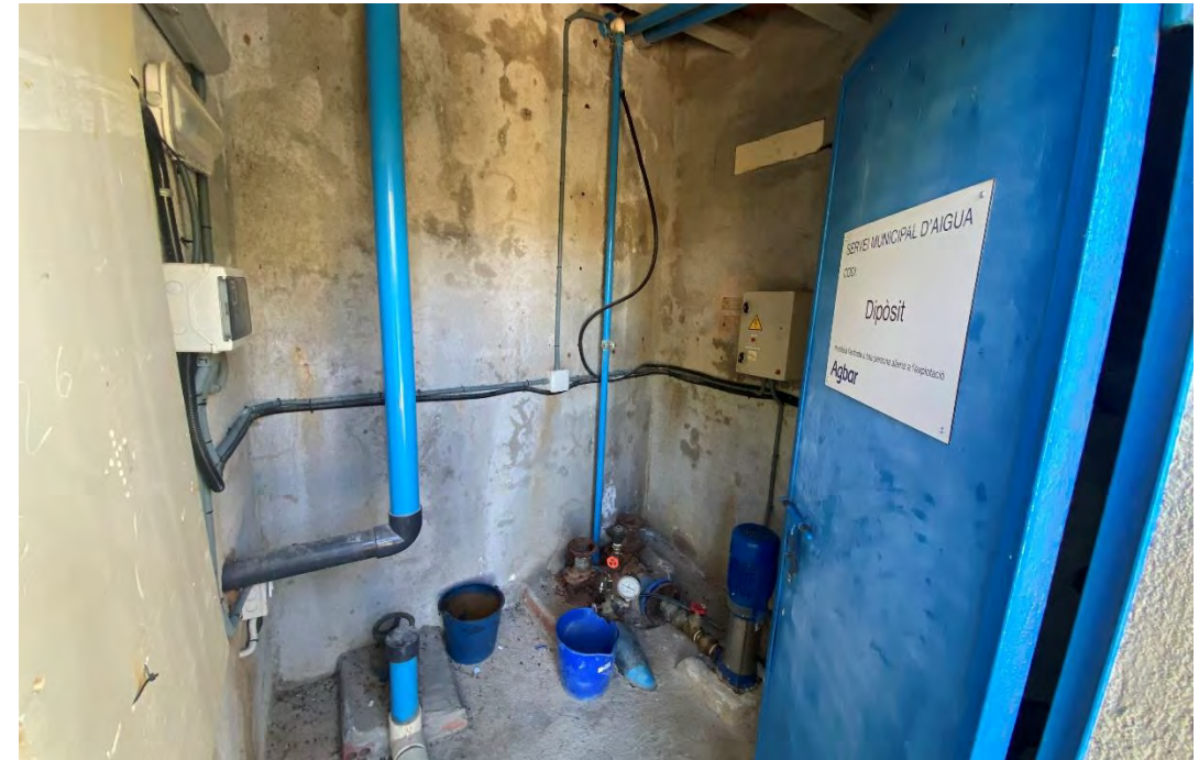
Figura 25. Interior caseta dipòsit 1 de Can Coll.
