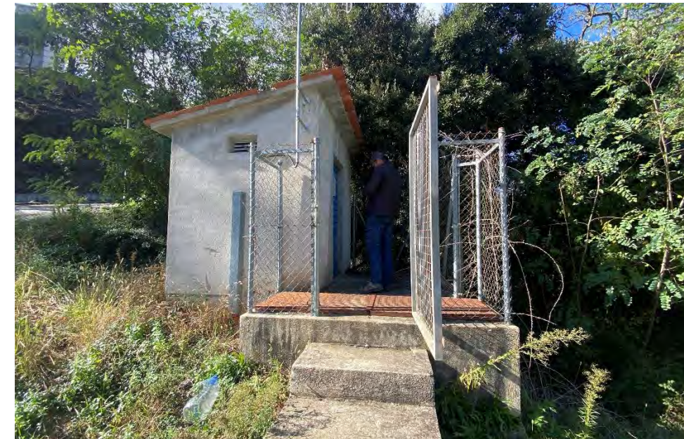
Figura 44. Cisterna Can Coll.
