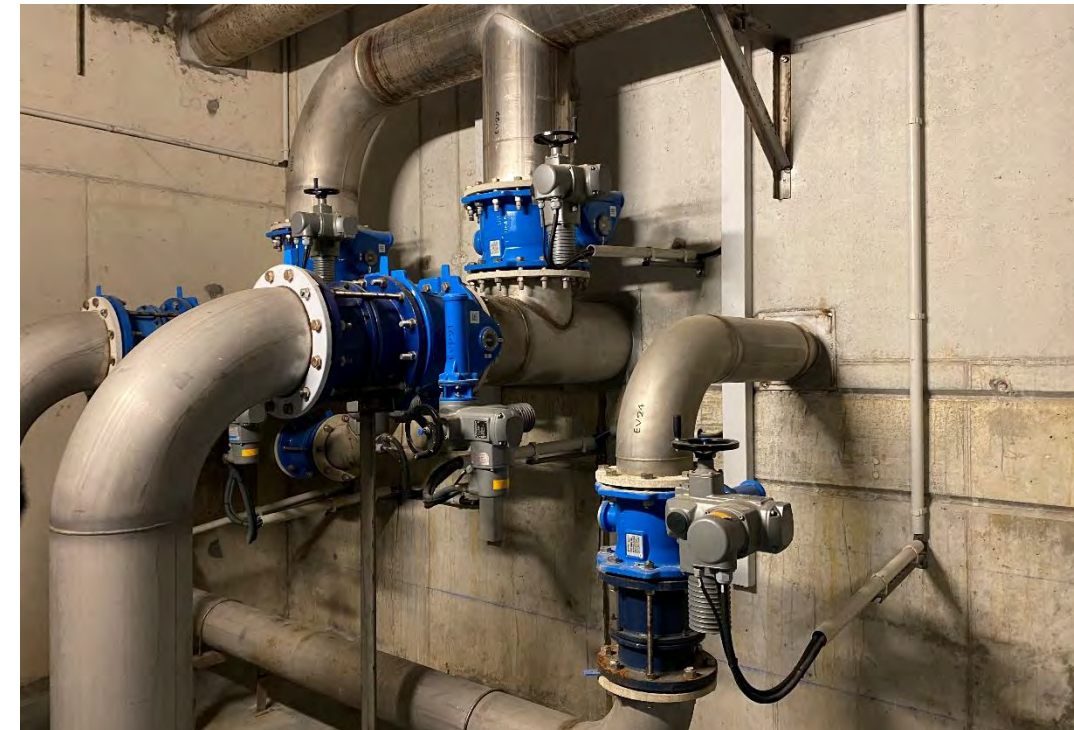
Figura 58. Válvules de papallona motoritzades.
