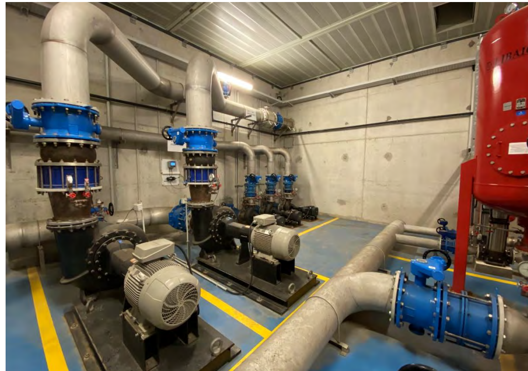
Figura 56. Bombes restat de filtres.
