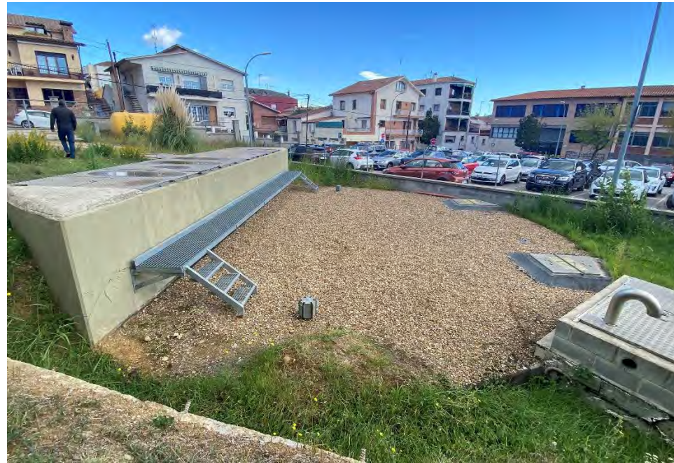
Figura 12. Dipòsit La Salle.
