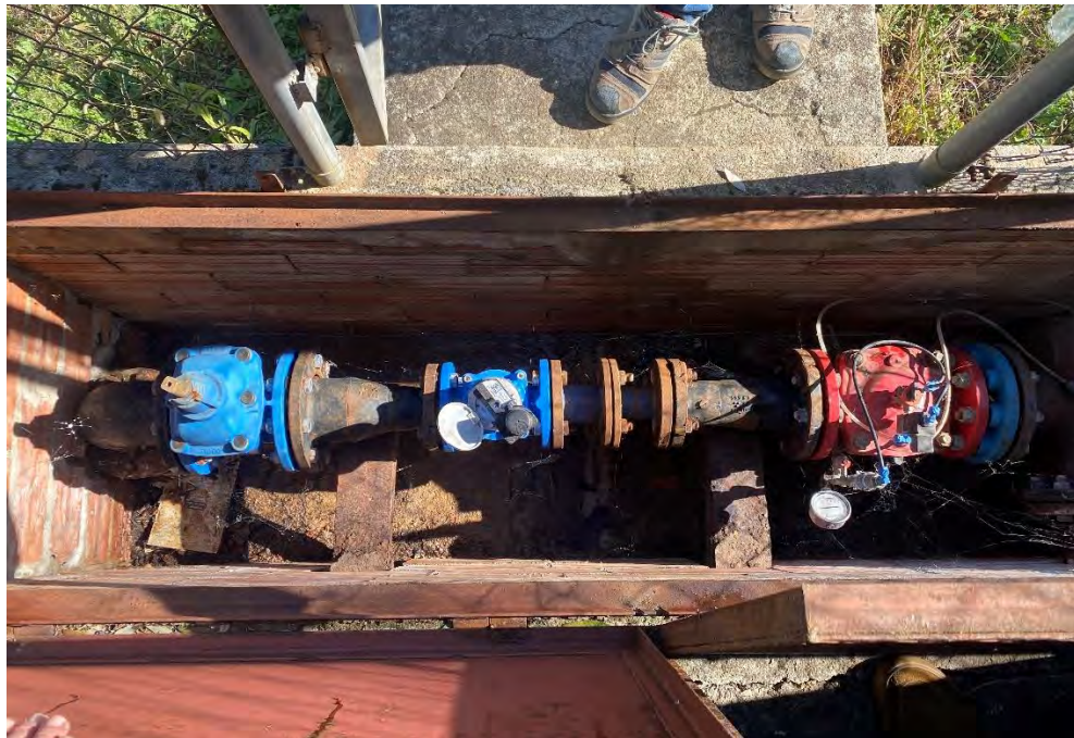
Figura 46. Comptador d'entrada.
