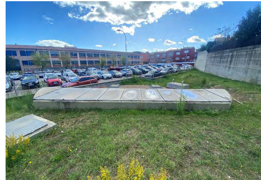
Figura 15. Accés superior dipòsit.
