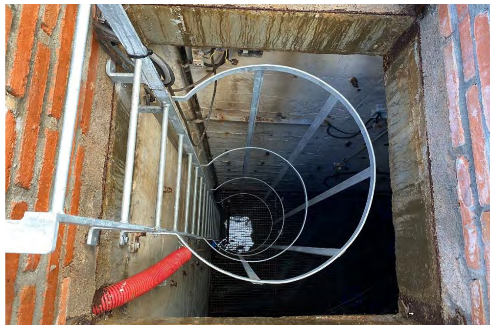
Figura 20. Accés interior dipòsit Turó Vell.
