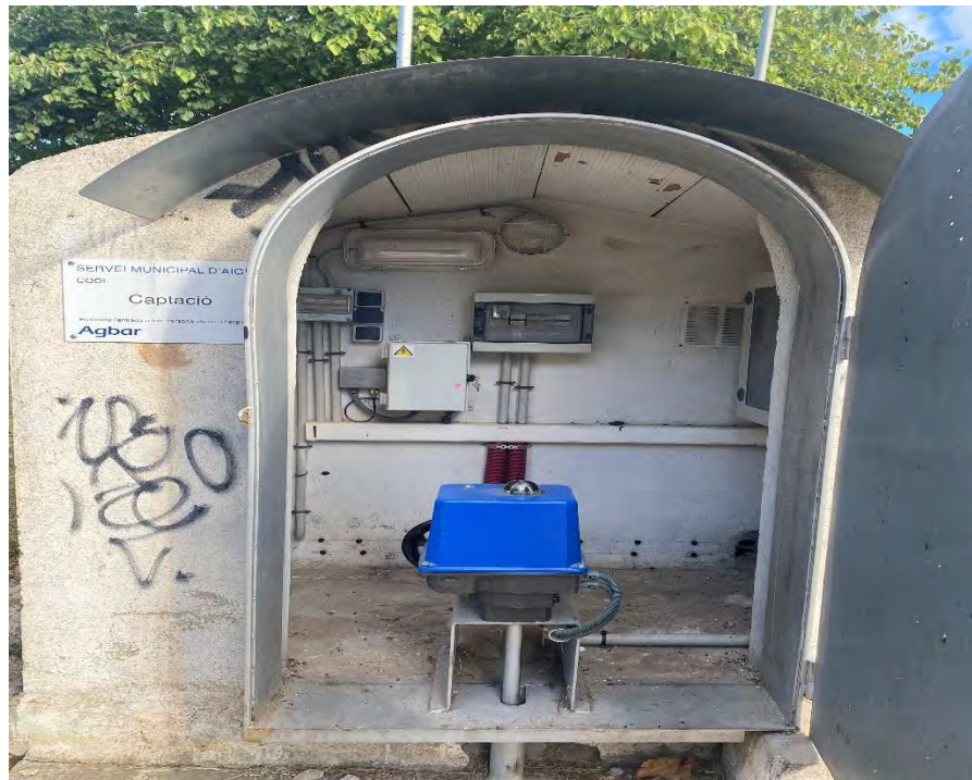
Figura 68. Comporta de seccionament.
