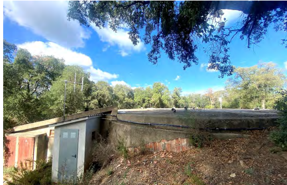
Figura 35. Exterior dipòsit Cal Batlle 2.
