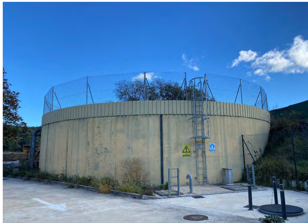
Figura 64. Dipòsit aigua producte. Dipòsit 1 de Can Sans.
