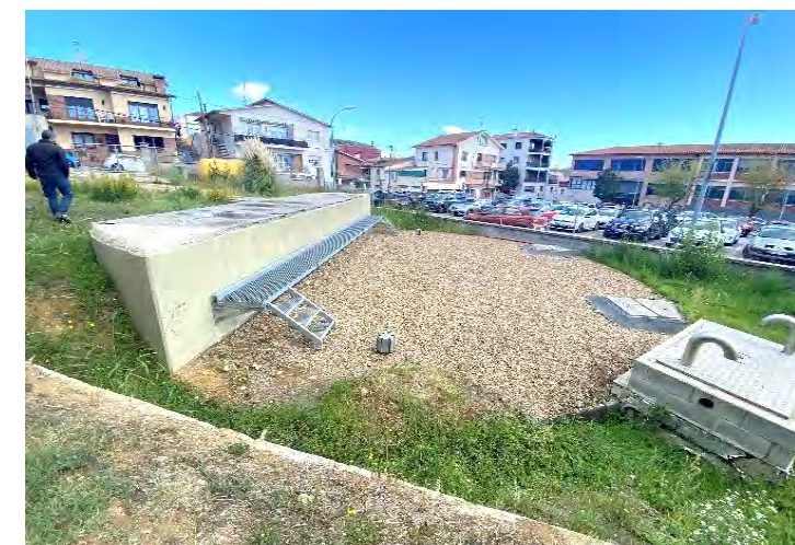
Figura 8 – Dipòsit de La Salle.
