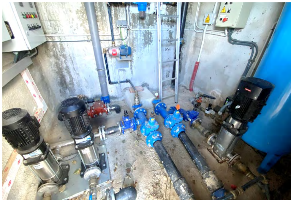
Figura 32. Grup de pressió de Boscos de Montnegre.
