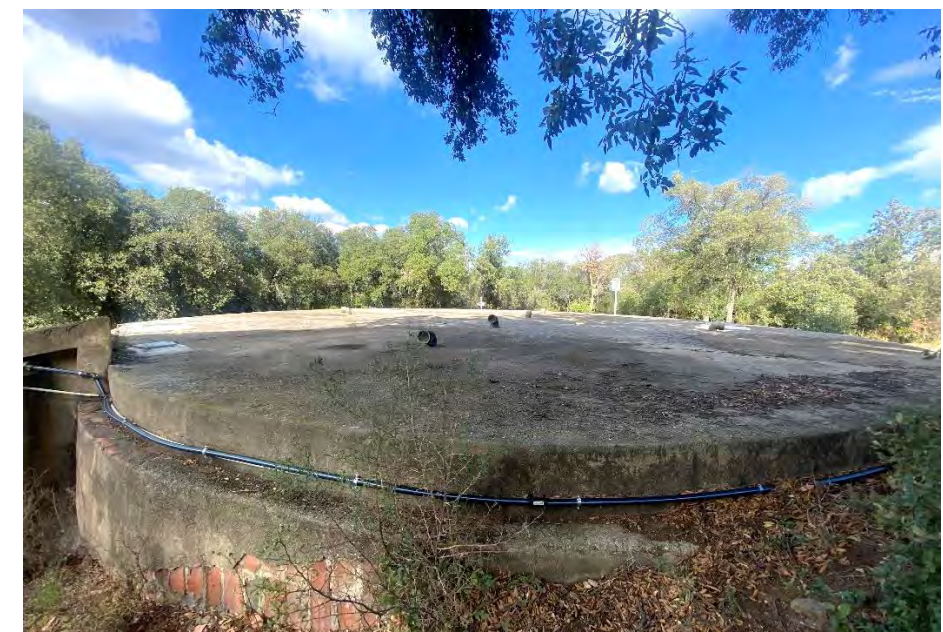
Figura 34. Coberta dipòsit Cal Batlle 2.
