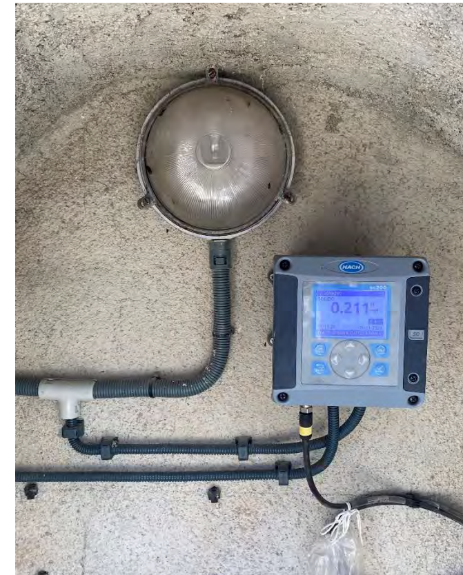
Figura 70. Analitzador multiparamètric.
