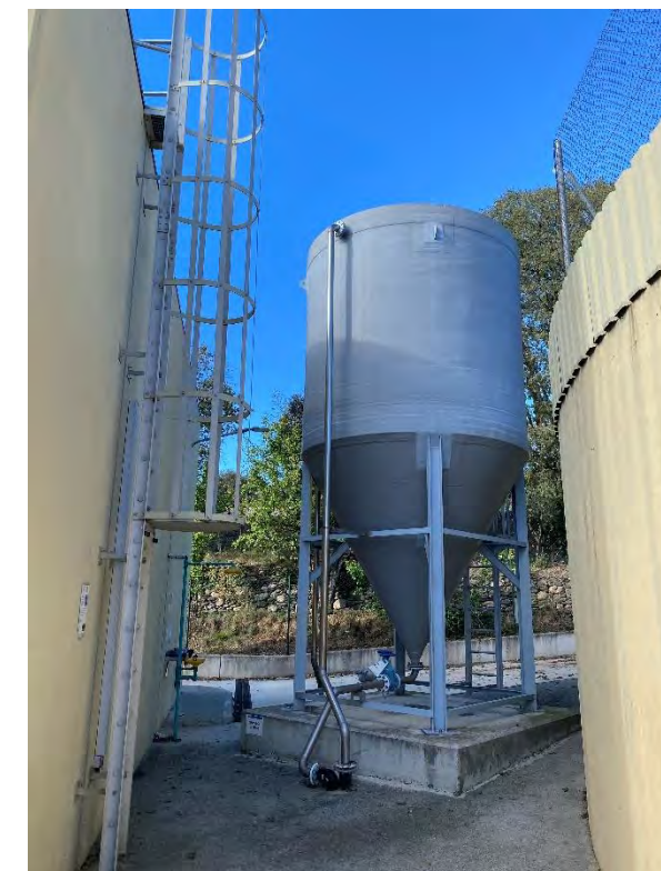
Figura 63. Espesidor de fangs.
