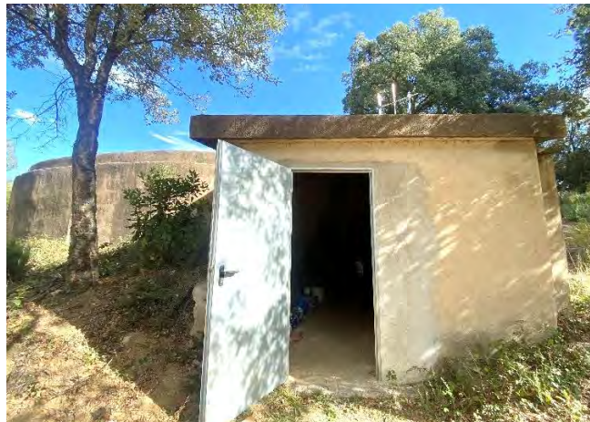
Figura 17 – Dipòsit Cal Batlle 2.
