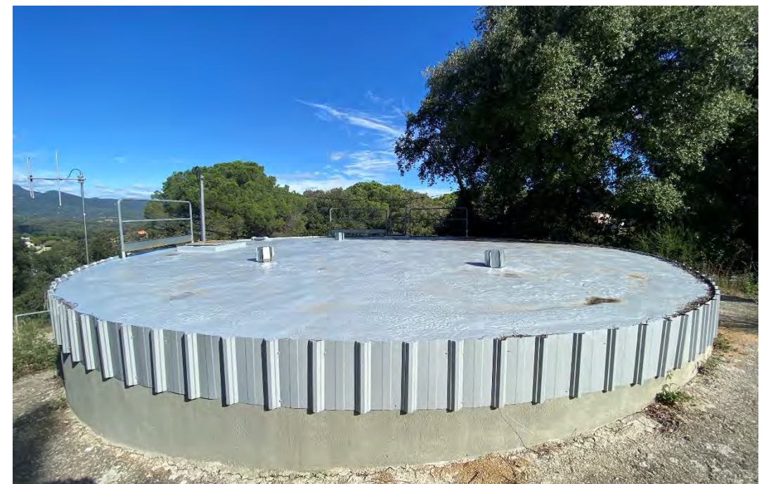
Figura 26. Coberta dipòsit 1 de Can Coll.
