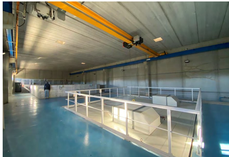
Figura 49. Vista general edifici ETAP.
