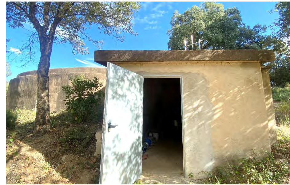
Figura 33. Exterior dipòsit Cal Batlle 2.
