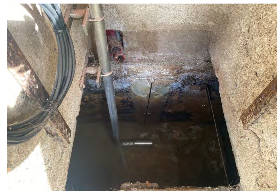
Figura 67. Parshall. Sensor de velocitat..
