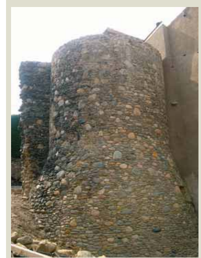
Els treballs d'adequació i restauració de part de la muralla i torre de la Força al carrer de les Valls entren a l'última fase. Fa pocs dies es va enderrocar el tros de paret de les antigues edificacions que amagava l'espai a la vista des del carrer. També s'han fet els últims treballs de prospecció arqueològica davant la torre que han permès estudiar la configuració del Sant Celoni antic.
