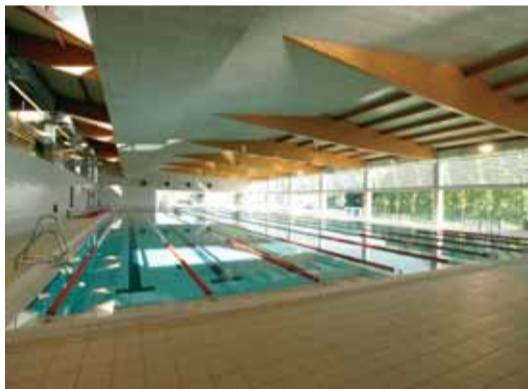
Piscina climatitzada de 25 x 16,6 m i piscina lúdica 16,6 x 8 m
