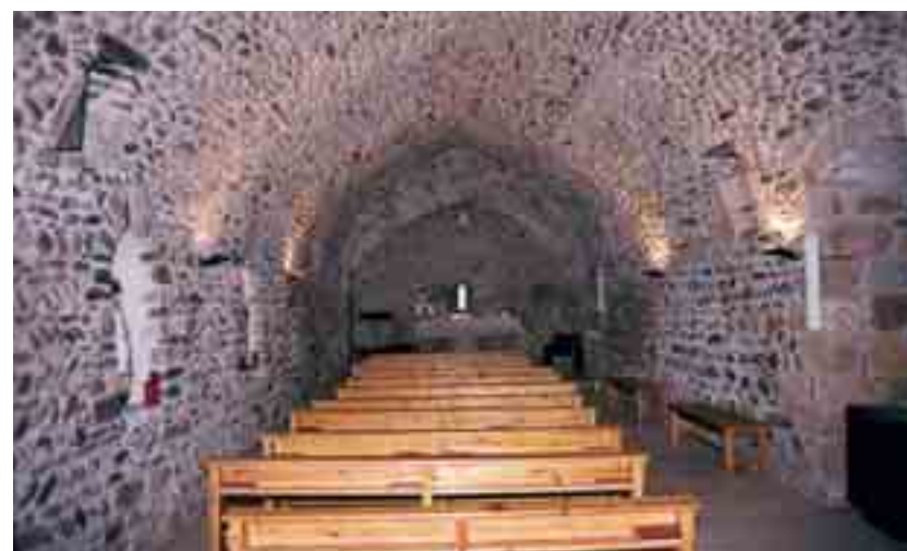
Interior, amb les parets repicades
