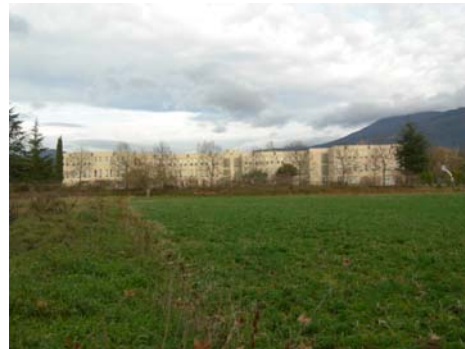
Aspecte general parcel·la per equipament educatiu
